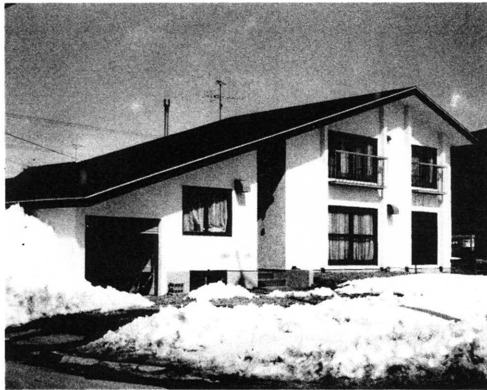
最初の2×4住宅(上)と半地下室のある住宅(下)
